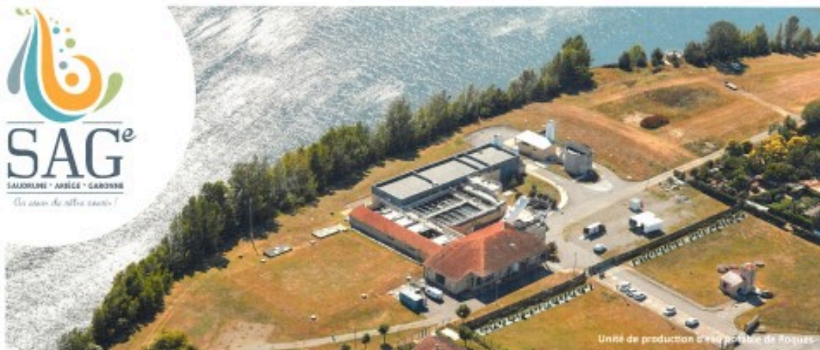
Unité de production d'eau potable de Roques
