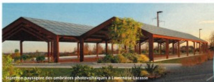
Insertion paysagère des ombrières photovoltaïques à Lavernose-Lacasse
